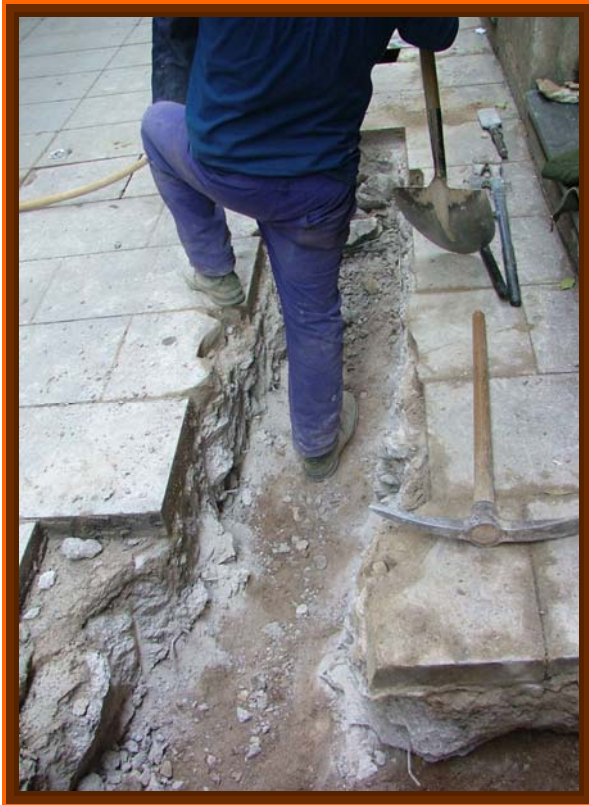
1. Fotografia on es veu la potència del formigó.
