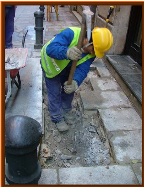
2. Operari picant formigó.
